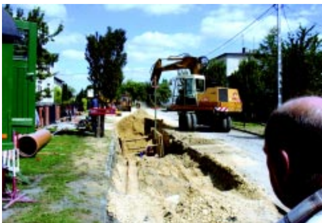
Roboty kanalizacyjne na ul. Chopina w Krotoszynie
